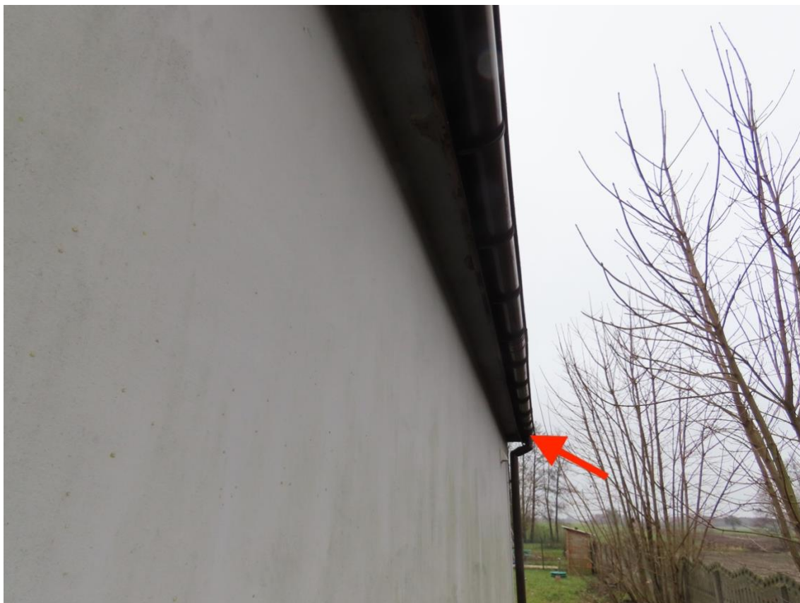
Fot. 3. Elewacja zachodnia od strony parkingów, zaznaczono miejsce gdzie jest szczelina pod stropem. Fot. B. Lesner
