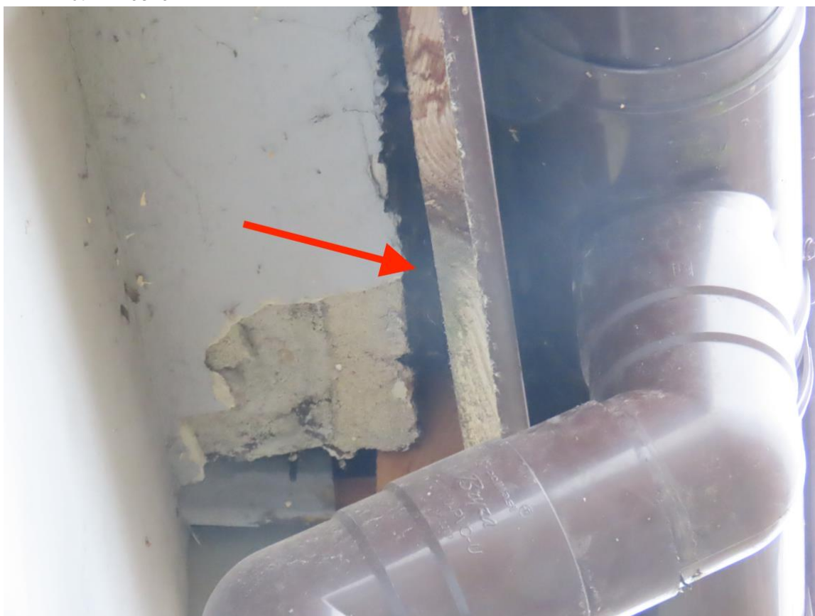
Fot. 4. Elewacja zachodnia od strony parkingów, zaznaczono miejsce gdzie jest szczelina pod stropem. Fot. B. Lesner
